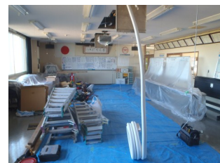
(写真上) 設置工事の様子
