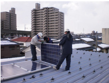
写真左：パネル設置の様子
