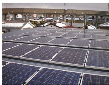
写真中央：完成したパネルの様子
